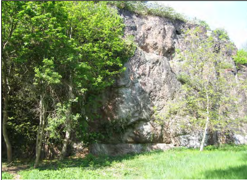
Fotoabb. 78: Porphywand entlang der Talstraße. Anja During, 03.05.2012
